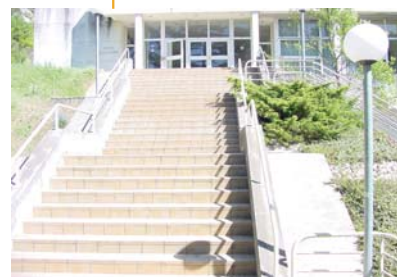
le Centre Pierre Gaudin (escalier d'accès)
